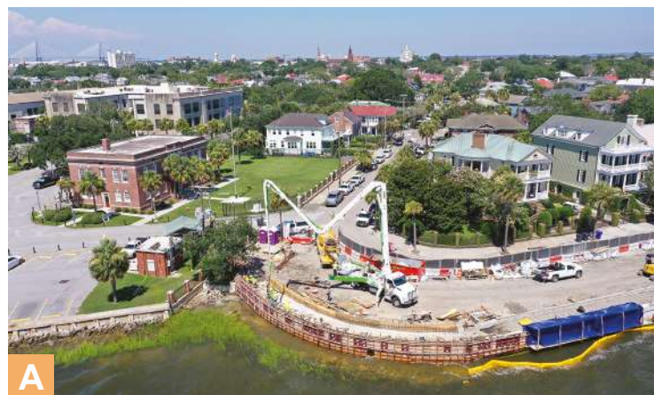
Figura. 3: Fase II del proyecto de dique de concreto: (a) una sección recta de colocación de concreto; y (b) el concreto colocado y el refuerzo GFRP instalado en la sección recta del dique
