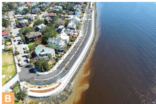
Figura. 2: Fase I del proyecto de dique de concreto: (a) colocación del concreto de la sección curva; y (b) sección curva del dique de GFRP terminada
