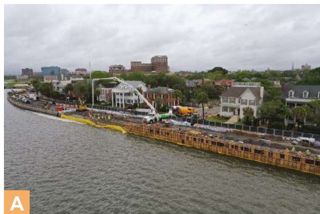
Figura. 2: Fase I del proyecto de dique de concreto: (a) colocación del concreto de la sección curva; y (b) sección curva del dique de GFRP terminada
