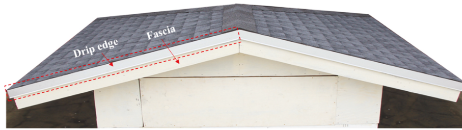
Fig. 24. Gable end drip edge and fascia.
